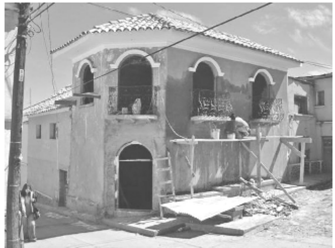
Revitalización de una vivienda en el centro histórico de Potosí. (Foto Arquitecto Luis Prado).
