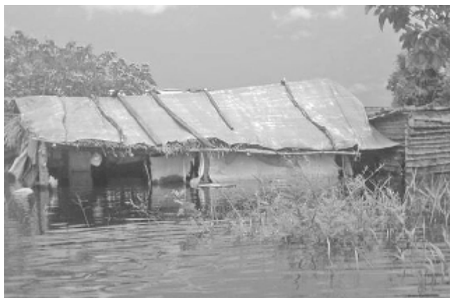
Vivienda anegada de agua – Area periurbana, Trinidad – Beni (febrero 2007). (Foto IIA).
