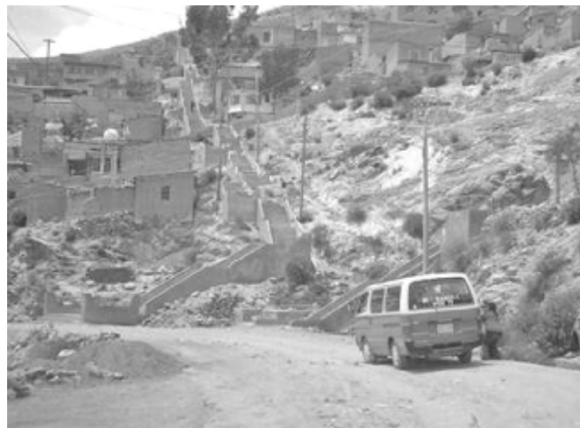
Asentamientos precarios Mejoramiento de la vialidad en áreas periurbanas – Departamento de Oruro. (Foto Arquitecto José Calderón).
