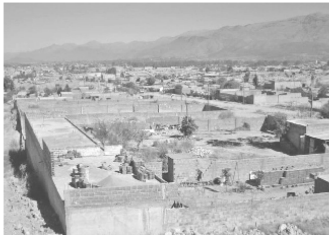
Extensas zonas de construcción de viviendas para sectores de bajos ingresos, Tarija – Bolivia. (Foto IIA).
