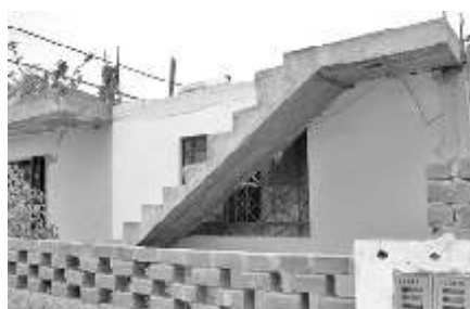
Escalera exterior (EE)
