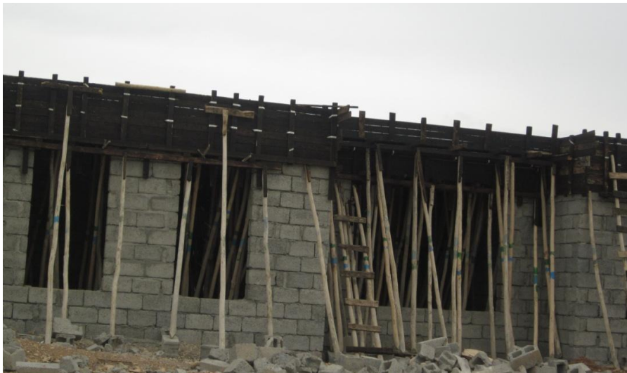
Figur 7.30 Form för gjutning av betong
