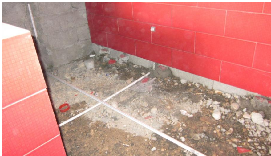
Figur 7.38 VVS-ledningar
