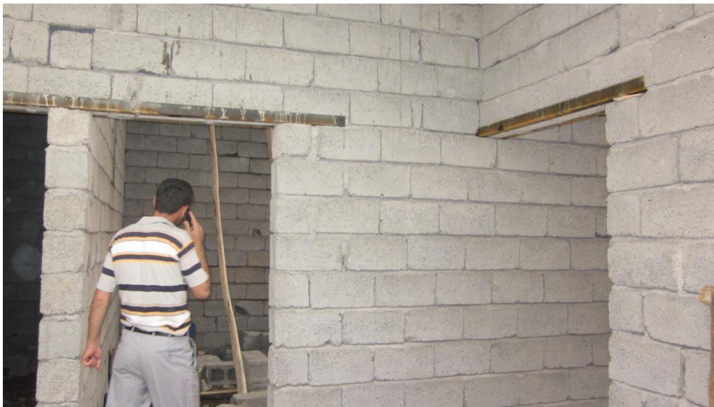
Figur 7.31 Stålbalkar ovanför dörröppningar
