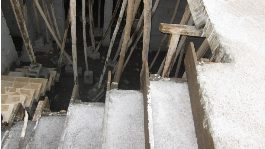
Figur 7.36 Formning och gjutning av trappa
