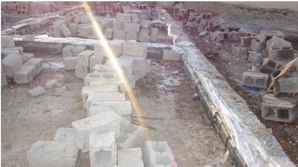
Figur 7.24 Betongblocksgrund i ett större projekt
