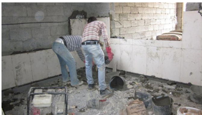
Figur 7.40 Kakelsättning på väggarna
