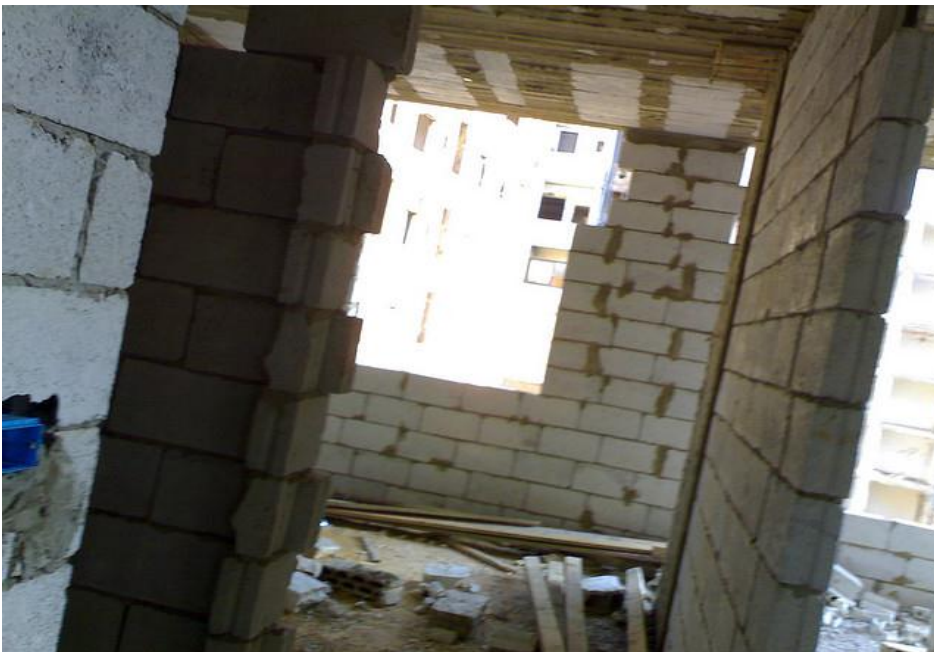
Figur 4.3 Illustration av typisk innerväggkonstruktion av betonghålstén
