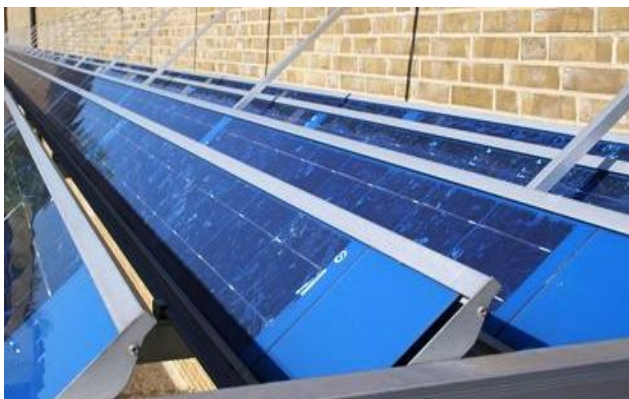
Utvändig solavskärmning med integrerade solceller.
