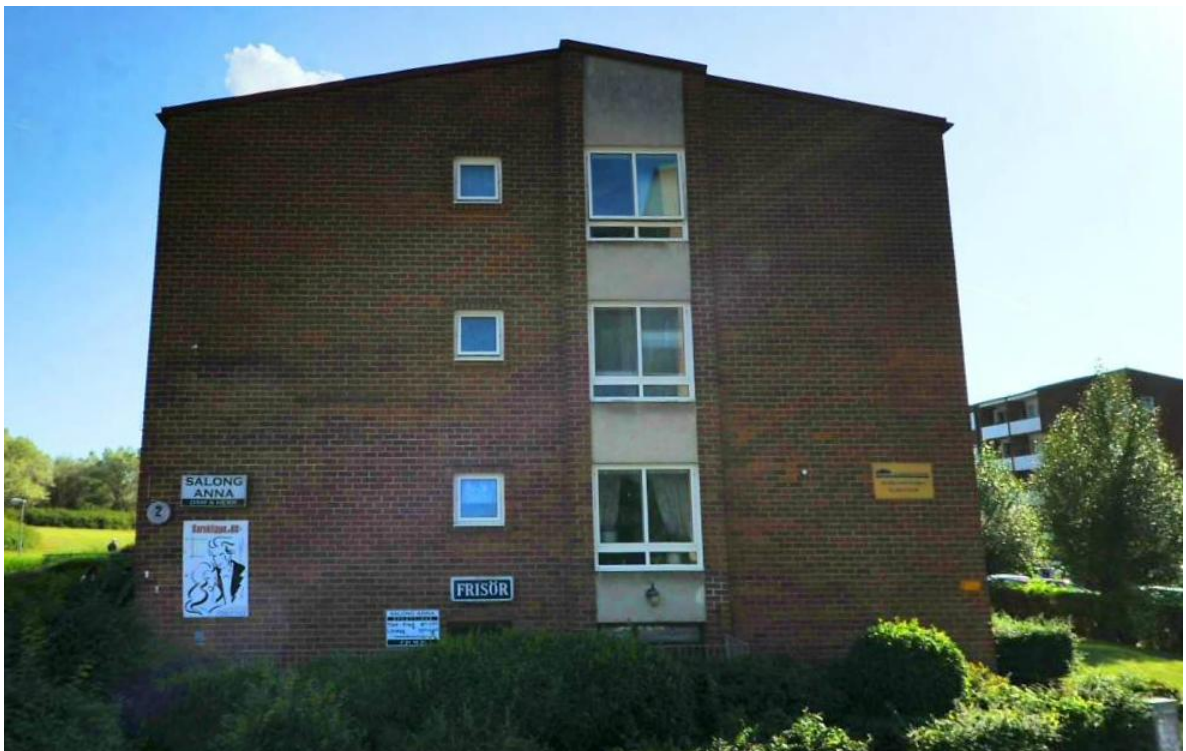
Norra fasaden av fastigheten Docenten 8
