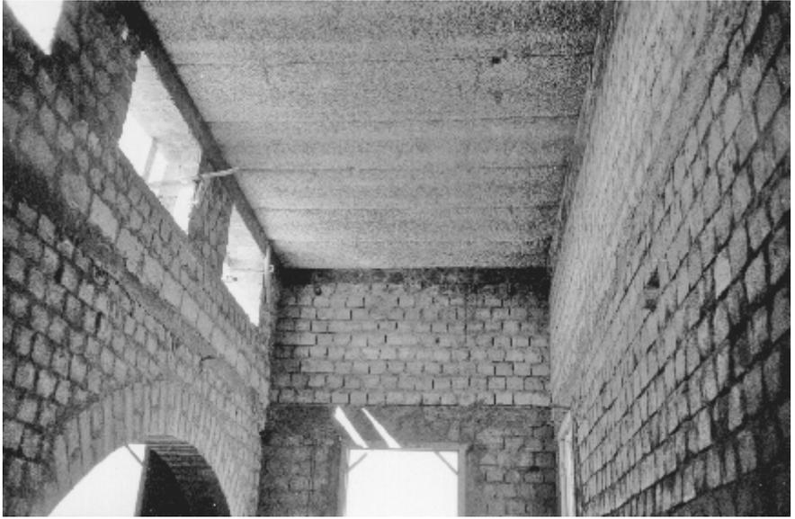
*Fig. 5.17 Les panneaux de laine de bois autoporteurs placés sur les murs en blocs de terre comprimée constituent une des plus importantes modifications apportées au bâtiment. La face inférieure des panneaux n'est pas revêtue pour obtenir une bonne acoustique dans le local*
