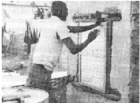
Installation des fenêtres avec garniture en feuilles de millet
