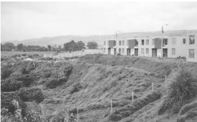
Fig. 3.11 Casas al borde de una quebrada.
