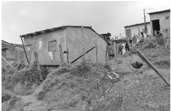
Fig. 2.1 Casas típicas de los asentamientos informales.
