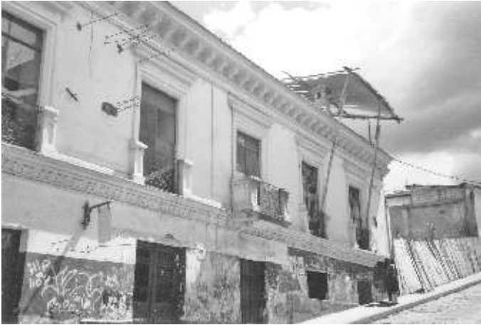
Fig. 3.3 Fachada de otro edificio del CHQ en proceso de recuperación.
