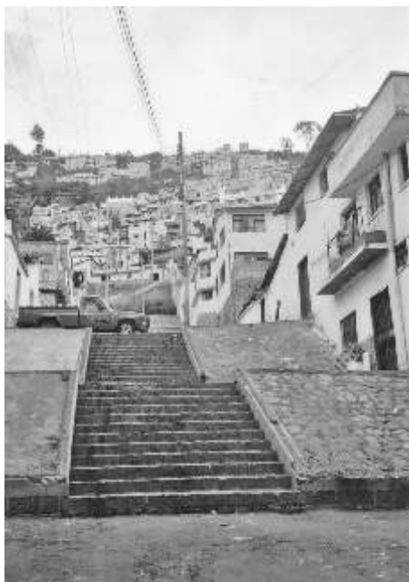
Fig. 2.4 Edificaciones en las laderas montañosas en Quito.
