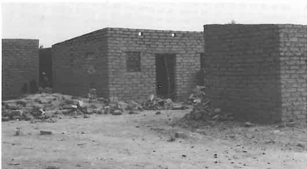
Bygge av nya bostadshus.
