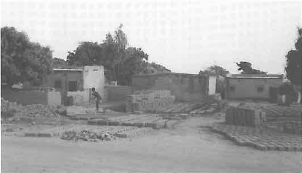
Lagring av adobeblock.
