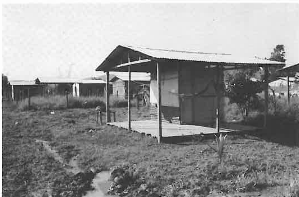
Nybyggd stomme med tak.
