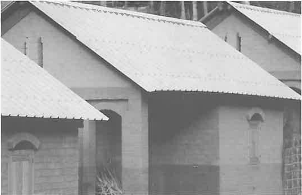
Nybyggt bostadshus av stabiliserade jordblock.
