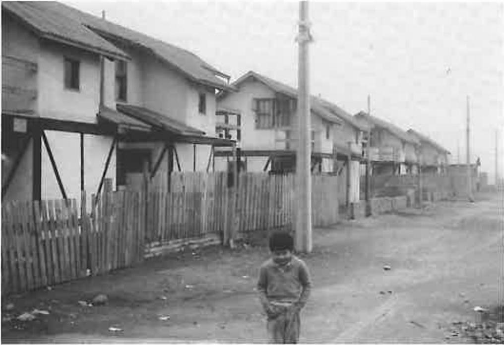
Nybyggda bostäder i stabiliserad jord.
