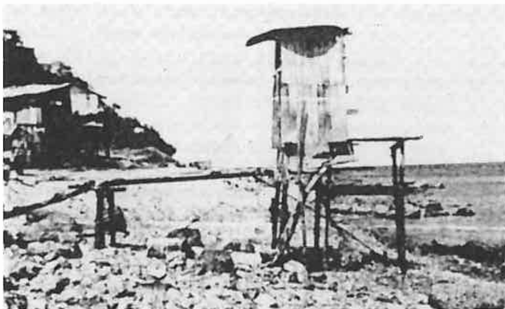
Toaletten rengöres av tidvattnet.
