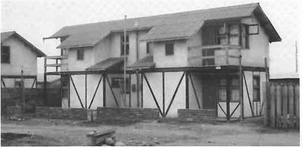
Bostadshus med stomme av träkonstruktion.
