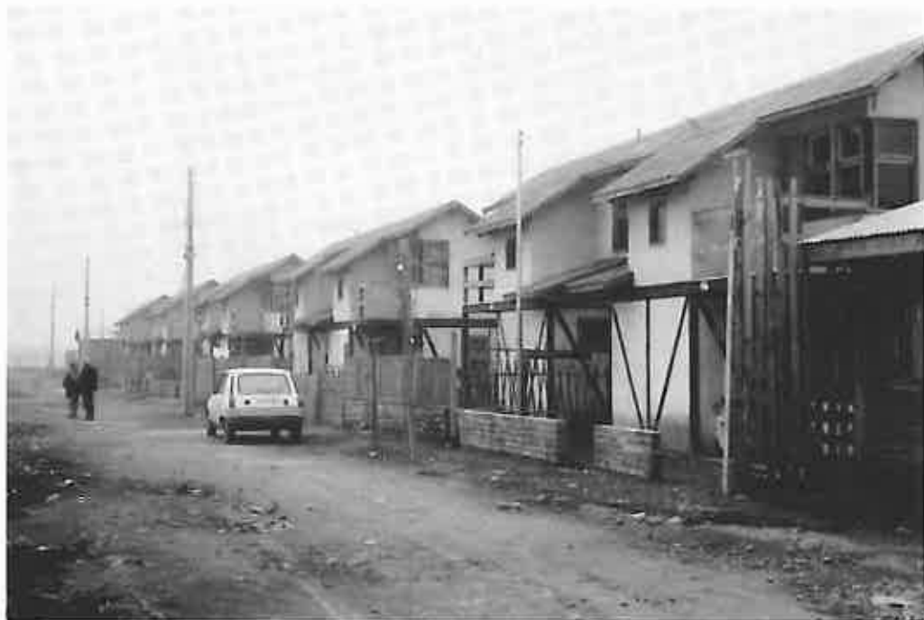
Nybyggda bostäder i stabiliserad jord.
