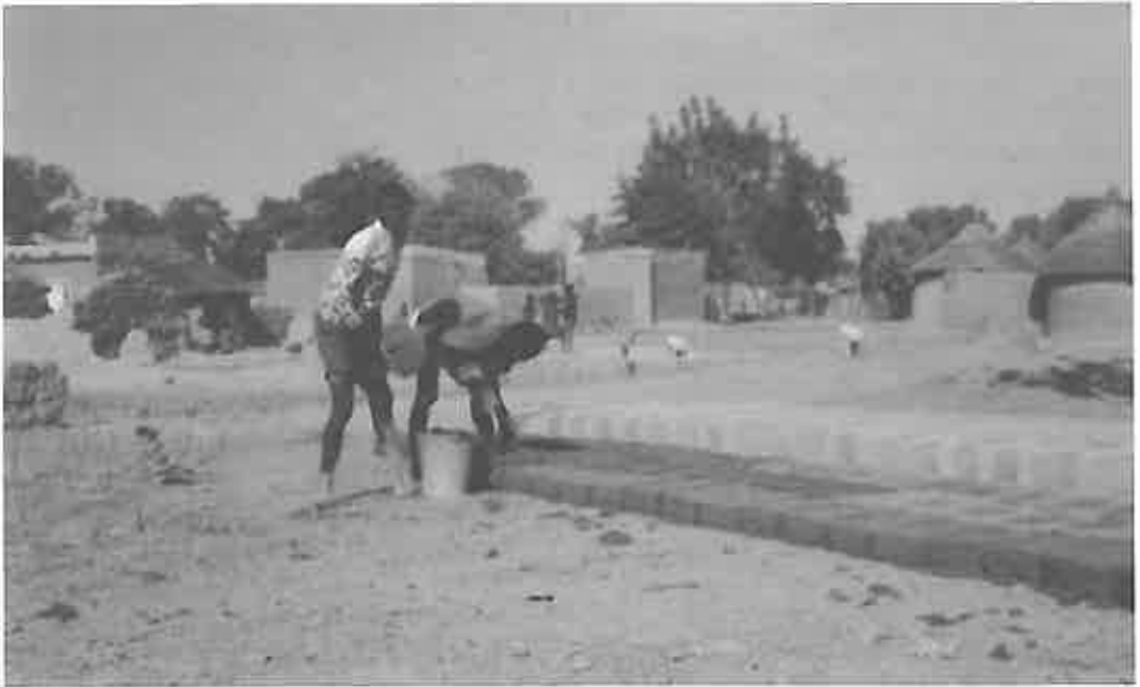
Tillverkning av adobeblock.
