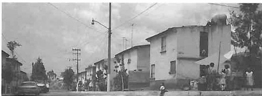
Basinfrastrukturen är färdig och gatorna belagda.
