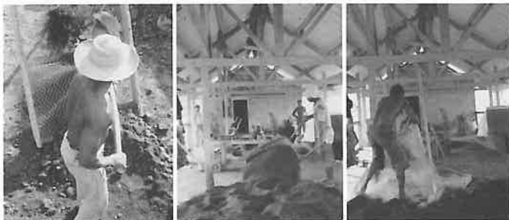
Tillverkning av stabiliserade jordblock.
