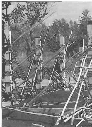
Stöttade formar för gjutning
