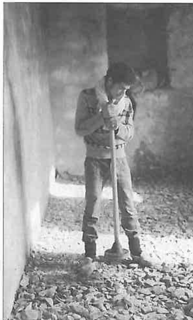
Komprimering av golvmaterial
