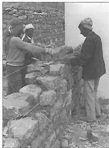
Murning av stenvägg
