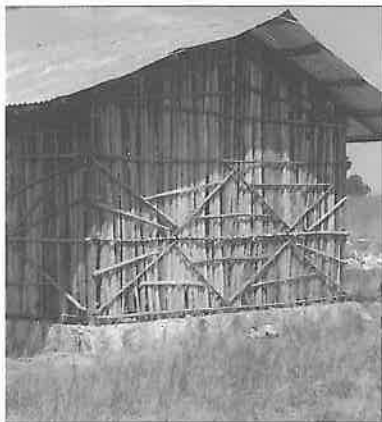
Rundträ i vägg
