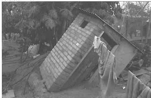
Skador av regnvatten
