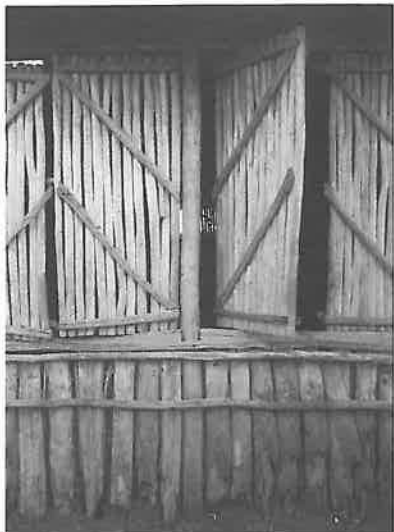
Termitangrepp på vägg
