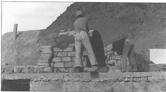
Murning av valvtak av cementstabiliserad jord, Tunisien
