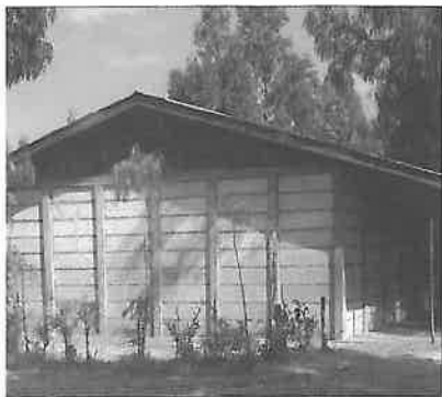
Vägg av förtillverkade betongelement, Etiopien
