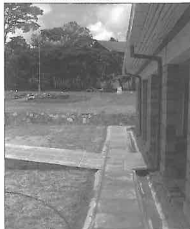
Stora takutsprång och hårdgjorda ytor närmast byggnaden skyddar huset mot regn
