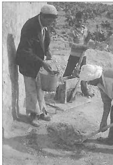
Tillverkning av cementstabiliserade jordblock.
