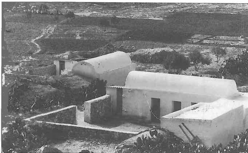
Bostäder byggda genom självbyggeri i Tunisien
